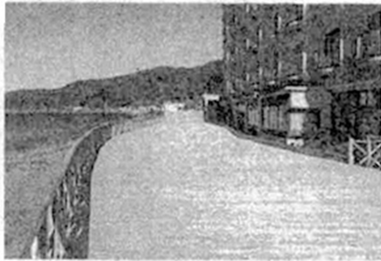
こうしゅうえんが新設した海岸デッキ（石川県輪島市）
